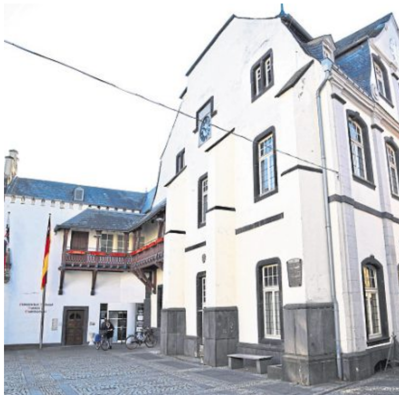
Der Vorplatz des Historischen Rathauses muss wegen Reparaturarbeiten am Dach zeitweise gesperrt werden. Foto: Stadt Andernach (Archiv)/Maurer
